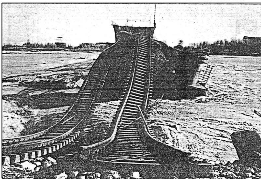
Foto 2 e 3 - novembre 1982: vedute del ponte dopo il crollo
