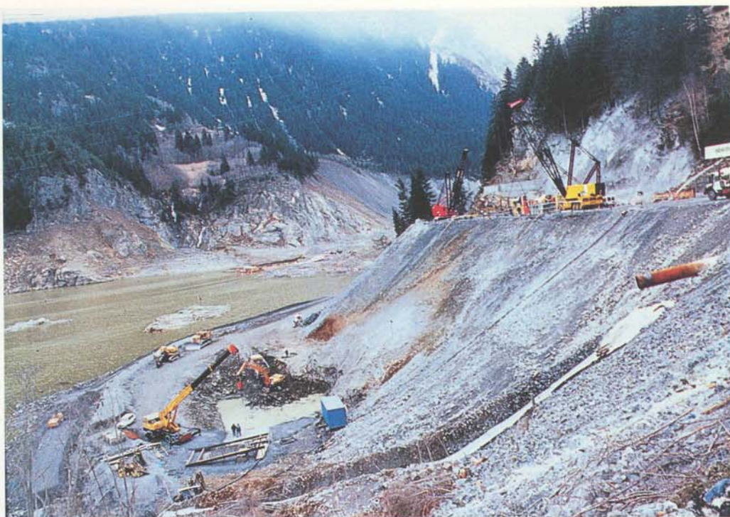
Fig. 6 (sopra) - Realizzazione dell'opera di presa a monte
