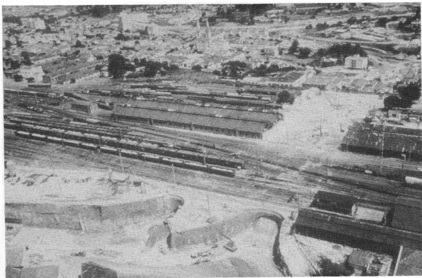
FIG. 7 - Sottopasso dello scalo ferroviario di Campinas (Brasile)
