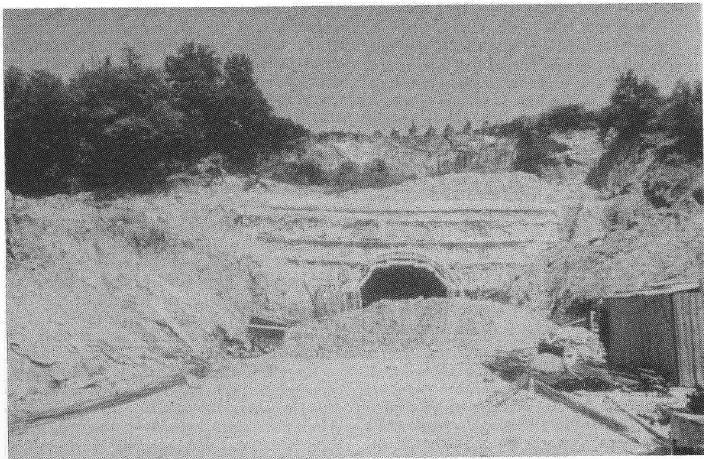
FIG. 6 - Imbocco della galleria Castiglione Ubertini dopo il dissesto
