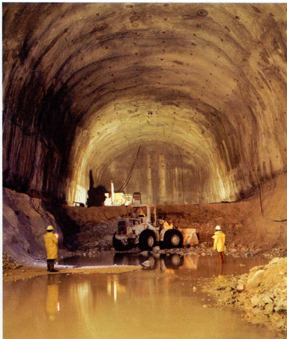
foto 1: Laboratorio Nazionale di fisica sub-nucleare del Gran Sasso - la caverna laboratorio "B" in fase di scavo
