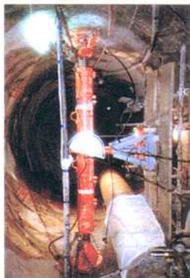
▲ Foto 5 - Galleria "Bellosguardo": prova di martinetto cilindrico nel foro pilota
