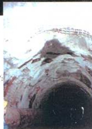
▲ Foto 2 - Galleria "Bellosguardo": distacco gravitativo nel foro pilota
