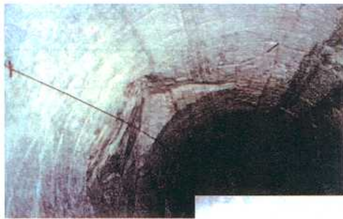
▲ Foto 2 - Galleria "Bellosguardo": distacco gravitativo nel foro pilota
