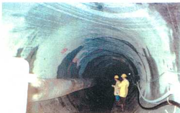
▲ Foto 1 - Galleria "Bellosguardo": rilievo geostrutturale da foro pilota presso prog. 1250 m
