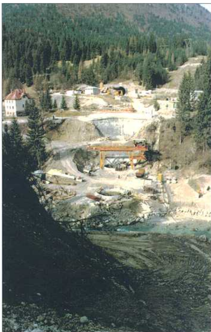
Vista dei lavori per la realizzazione delle fondazioni della spalla "Udine" e delle pile 1, 2, 3. Sullo sfondo l'imbocco Nord della galleria "Camporosso"
