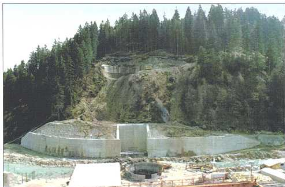
Vista dei lavori di stabilizzazione del versante Nord (spalla "Austria")
