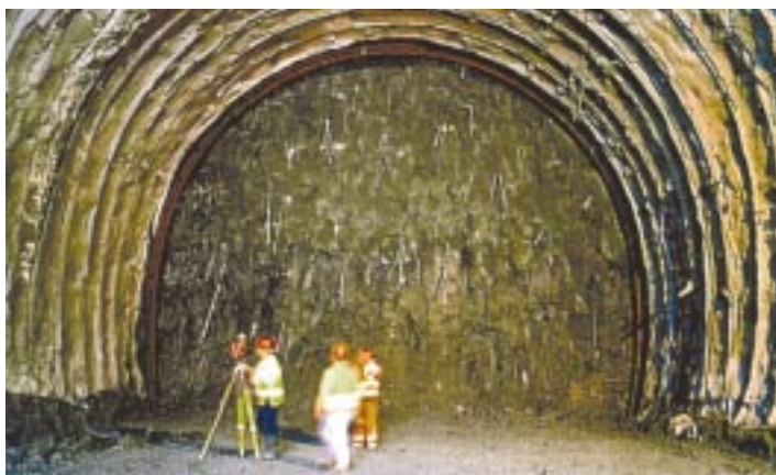
Foto 5: Galleria Pianoro (linea ferroviaria ad alta velocità Milano-Napoli, tratta Bologna-Firenze, terreno: sabbia limosa cementata, copertura: 150 m, diametro: 13.30 m). Vista del fronte consolidato con elementi strutturali di vetroresina.
