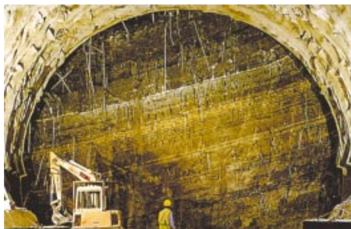
Foto 4: Galleria Tartaignulle [Francia, TGV Méditerranée, linea Marsiglia-Lione, terreno: argilla rigonfiante (75% di montmorillonite), copertura: 100 m, diametro: 15 m]. Vista del fronte (180 m 2 di sezione) consolidato con elementi strutturali di vetroresina.
