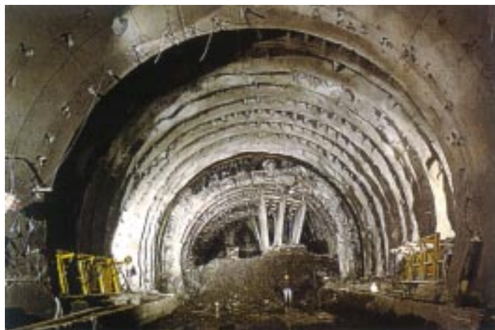
Foto 1: Galleria S. Stefano (linea ferroviaria Genova-Ventimiglia, terreno: flysch marnoso-calcareo tettonizzato e laminato, copertura: 150 m, diametro: 12 m). Collasso della cavità.
