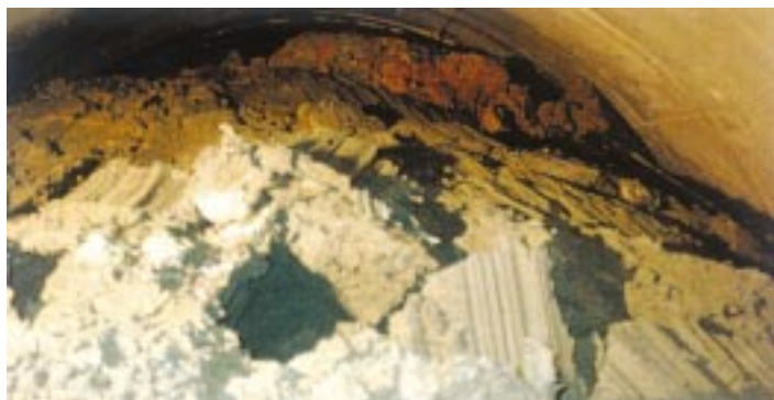
Foto 2: Galleria Vasto (linea ferroviaria Ancona-Bari, terreno: argilla limosa, copertura: 135 m, diametro: 12,20 m). L'estrusione del terreno attraverso il fronte durante lo scavo a mezza sezione (conformemente ai principi del NATM).
