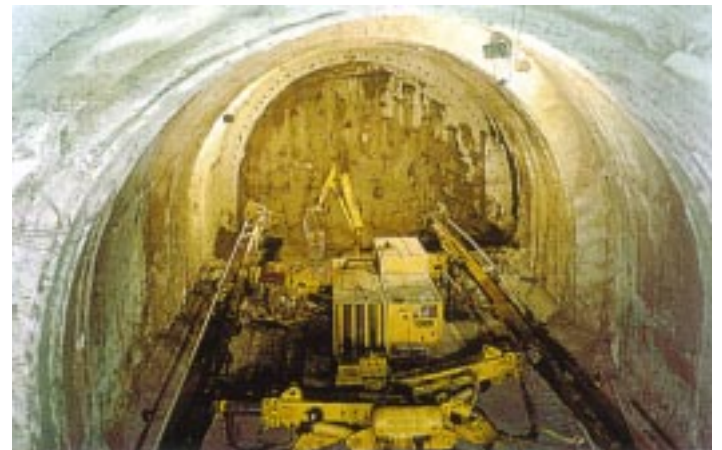
Foto 3: Galleria Vasto: consolidamento del fronte d'avanzamento con tubi di vetroresina durante l'avanzamento a piena sezione (conforme ai principi dell'approccio A.DE.CO.-RS).
