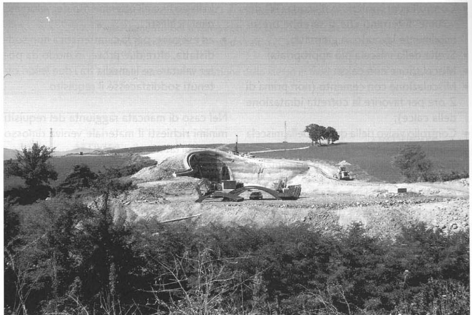
Foto 1 - Galleria Borgo Rinzelli: vista dell'imbocco nord. Photo 1 - Borgo Rinzelli tunnel: view of the northern portal.
