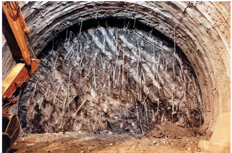
Fig. 3 View of a reinforced face. Bild 3 Ansicht einer verstärkten Ortsbrust.
