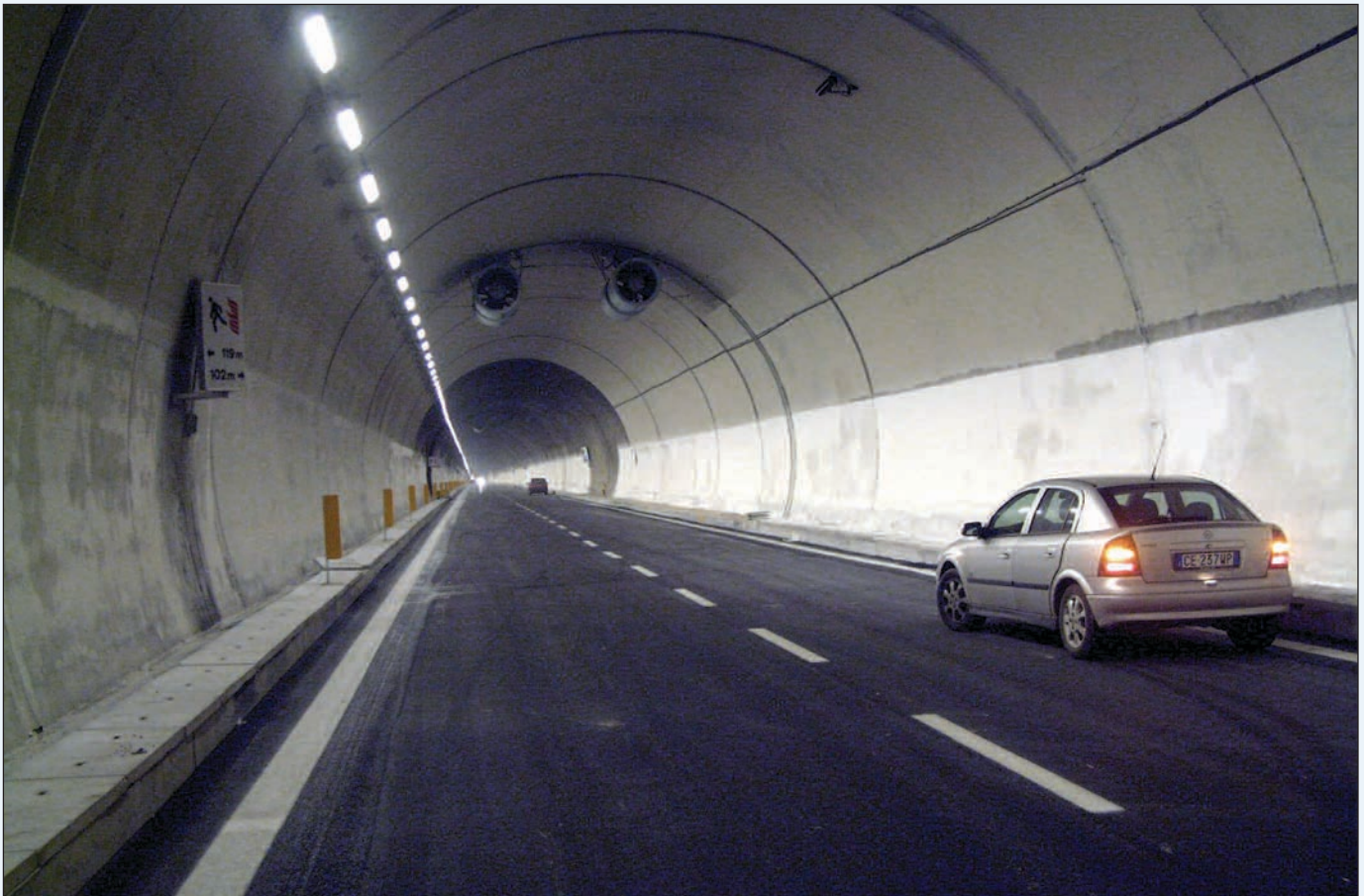
L'imbocco della canna di valle lato Aosta pochi giorni prima dell'entrata in esercizio della galleria
