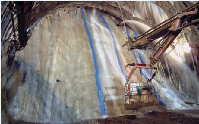
Il fronte della canna di monte lato Monte Bianco alla prog. 3+546 il 13 Giugno 2005 in assenza di drenaggi
