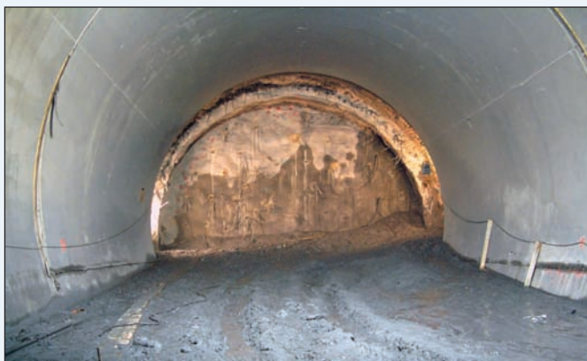
La venuta fangosa nella canna di monte lato Aosta il 13 Giugno 2003
