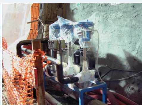
Le valvole di regolazione dell'alimentazione in galleria
