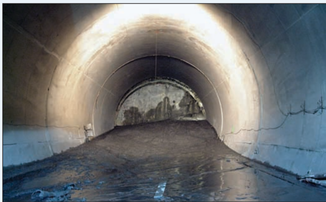
La venuta fangosa nella canna di monte lato Aosta il 16 Giugno 2003
