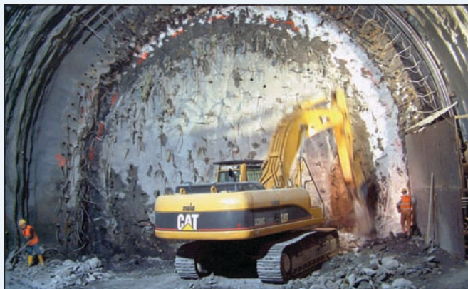
Il fronte della canna di monte durante lo scavo sotto mantenimento
