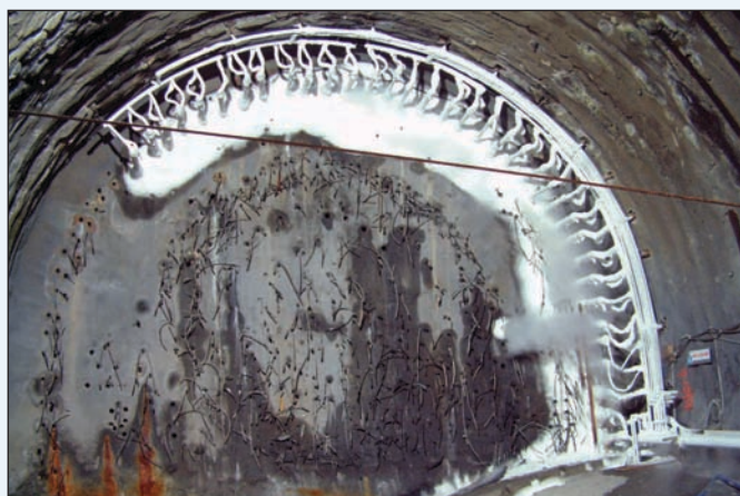
Il fronte della canna di monte durante il congelamento, situazione del fronte 24 ore circa prima dell'interruzione del flussaggio per consentire lo scavo
