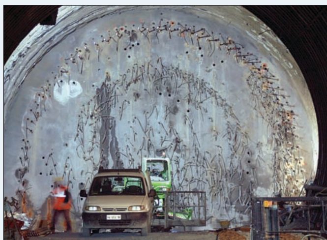
Il completamento degli interventi di consolidamento del tampone di fondo dal camerone di lavoro del primo campo congelato in canna di monte Aosta
