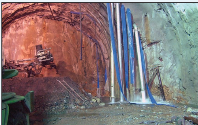
Il fronte della canna di monte lato Monte Bianco alla prog. 3+546 il 20 Luglio 2005 una volta eseguiti i drenaggi
