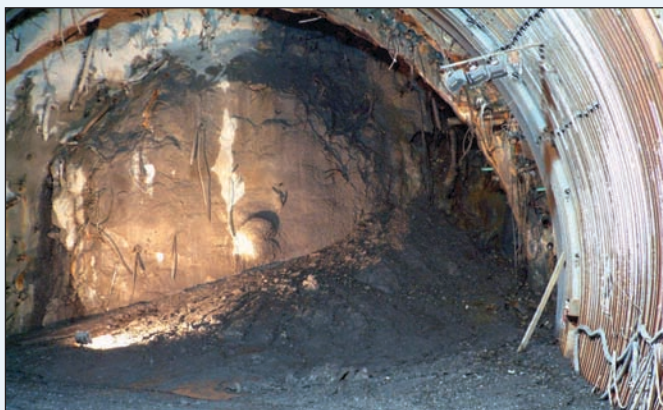
La venuta fangosa nella canna di monte lato Aosta, dopo una serie di inutili tentativi di contenimento, riprende il 30 Settembre 2003
