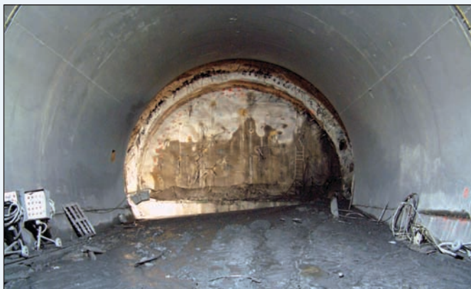
La venuta fangosa nella canna di monte lato Aosta il 12 Giugno 2003
