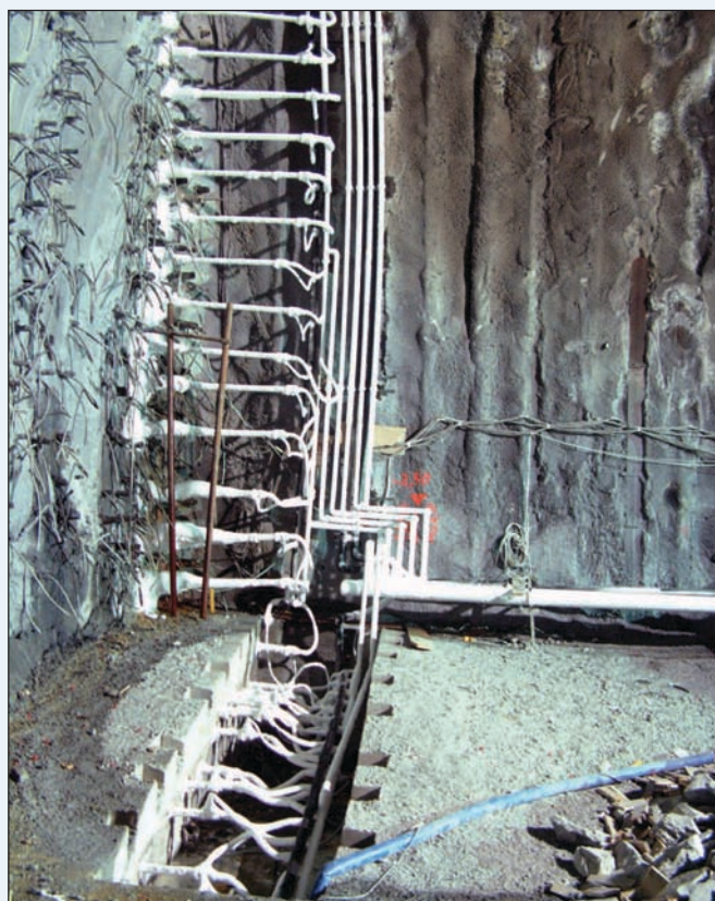
Particolare della trincea realizzata per la messa in opera delle sonde congelatrici sotto l'arco rovescio
