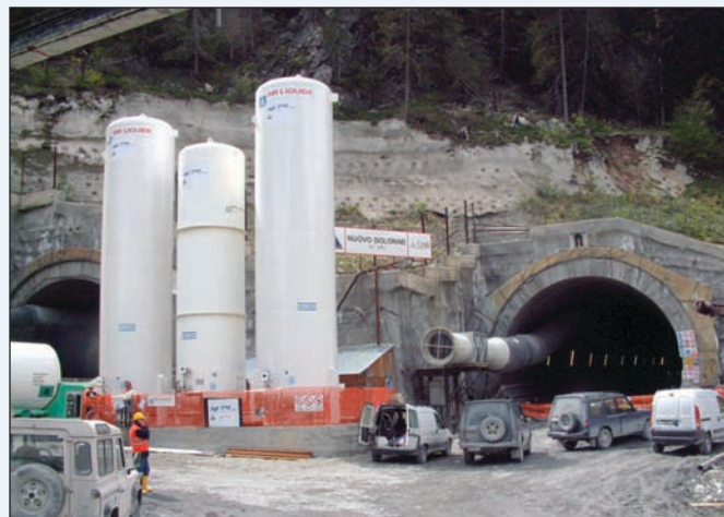
I silos per lo stoccaggio dell'azoto liquido nel piazzale di imbocco lato Aosta
