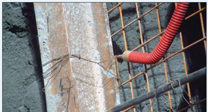
La cella di pressione fissata all'estradosso della centina
