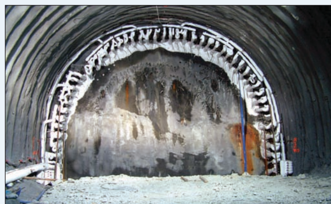
Il fronte della canna di valle durante il congelamento, situazione del fronte prima dell'inizio dello scavo
