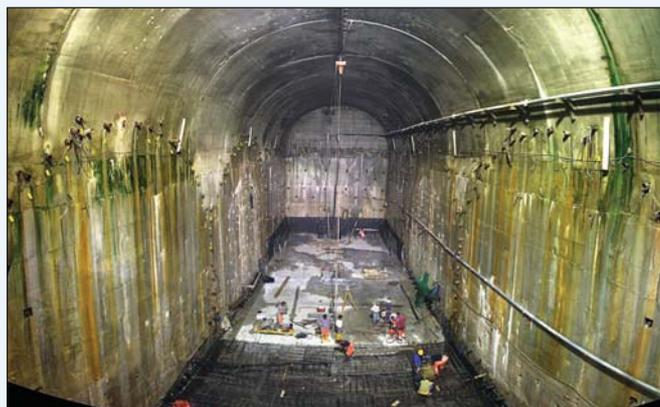
Figura 10 - La stazione Toledo: il camerone di scavalco da cui partono le gallerie di banchina
