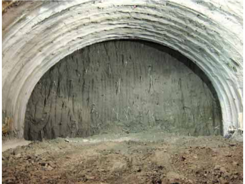
Figura 7 - Galleria di stazione Corvetto: formazione Marne di Piccapietra
