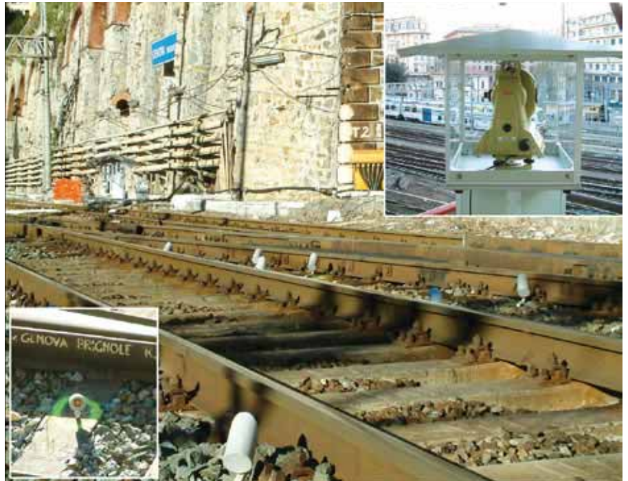
Figura 11 - Monitoraggio rilevato ferroviario
