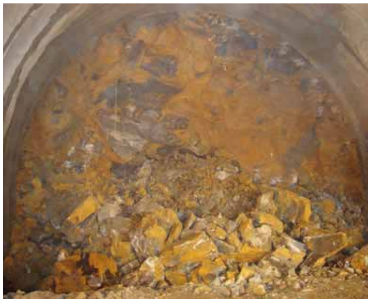
Figura 8 - Galleria di linea: formazione calcari di Monte Antola
