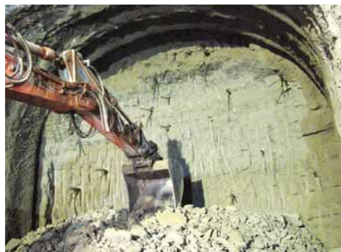
(in basso) Foto 13 e 14 Attacco scavi Corvetto: fasi di scavo e getto
