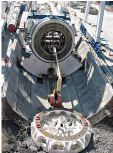
Foto 2 – La TBM-EPB “Martina” durante la fase di montaggio.
