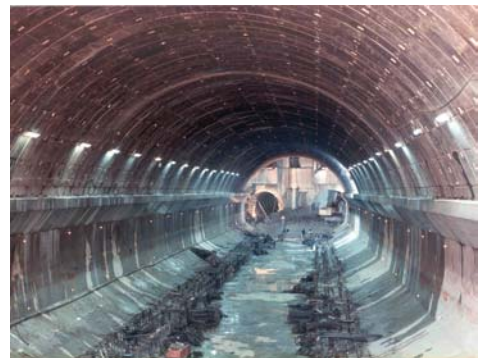
Vista della galleria di stazione completata
