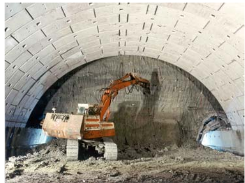
Fase di scavo della calotta
