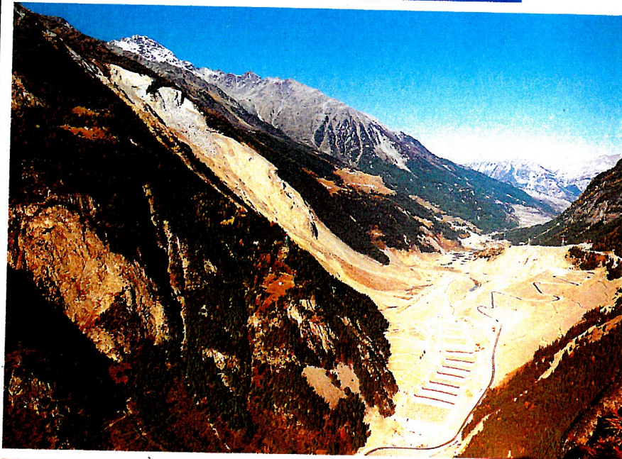
Al centro: L'area della frana in Valtellina dopo il consolidamento. Nelle altre illustrazioni: la sezione al computer e gli scavi della galleria del Passante ferroviario di Milano con il nuovissimo sistema utilizzato.
